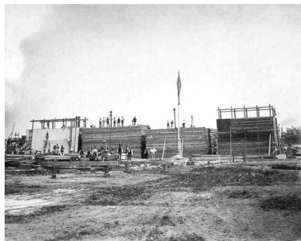
Egetræ sænkekasser til Middelgrunden bygget i Tuborg Havn
